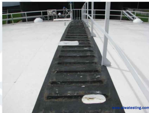
รูปที่ 7 การกัดกร่อนของหลังคาถัง รูปที่ 8 การกัดกร่อนของบันไดบนหลังคาถัง
