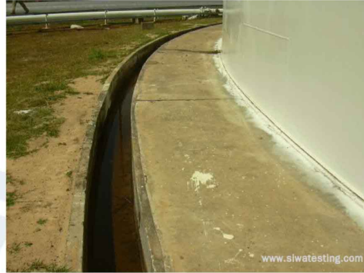
รูปที่ 4 แบบของฐานถัง แบบแอสฟัลท์ (ซ้าย) และแบบคอนกรีต (ขวา)
