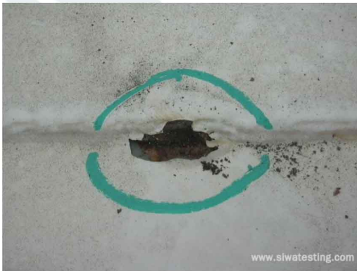
รูปที่ 7 การกัดกร่อนของหลังคาถัง รูปที่ 8 การกัดกร่อนของบันไดบนหลังคาถัง
