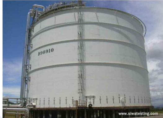
รูปที่ 1 ถังเก็บน้ำมันเชื้อเพลิงเหนือพื้นดิน แบบติดตั้งบนพื้นดินโดยตรง (ซ้าย) และ ตัวอย่างถังเก็บก๊าซเหลว ที่มีลักษณะเดียวกับถังเก็บน้ำมันเชื้อเพลิงเหนือพื้นดินแต่ติดตั้งบนฐานคอนกรีต (ขวา)
