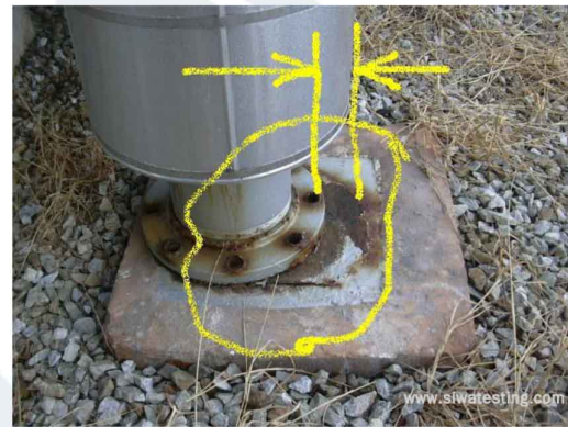
รูปที่ 12 ท่อเคลื่อนเคลื่อนขยับไปจากตำแหน่งเดิม
