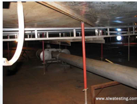
รูปที่ 16 ผลการทดสอบ MFL ที่พบการเสียความหนา รูปที่ 17 สภาพภายในถัง ที่มีหลังคาลอยภายใน
