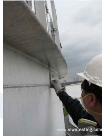
รูปที่ 6 เหล็กรัดปากถังโก่ง อาจเกิดจากความดันเกิน
