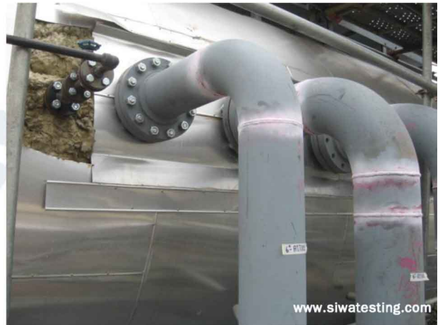
การตรวจสอบ การกัดกร่อนภายใต้ฉนวนของท่อที่ผ่านการใช้งานมานานและมีอุณหภูมิทำงานในช่วงที่เกิดการกัดกร่อนได้ง่าย
