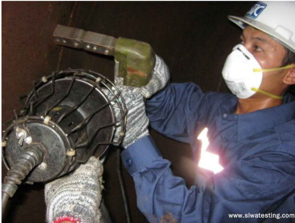
ทดสอบรอยเชื่อมด้วยผงแม่เหล็ก (Magnetic Particle Test)
