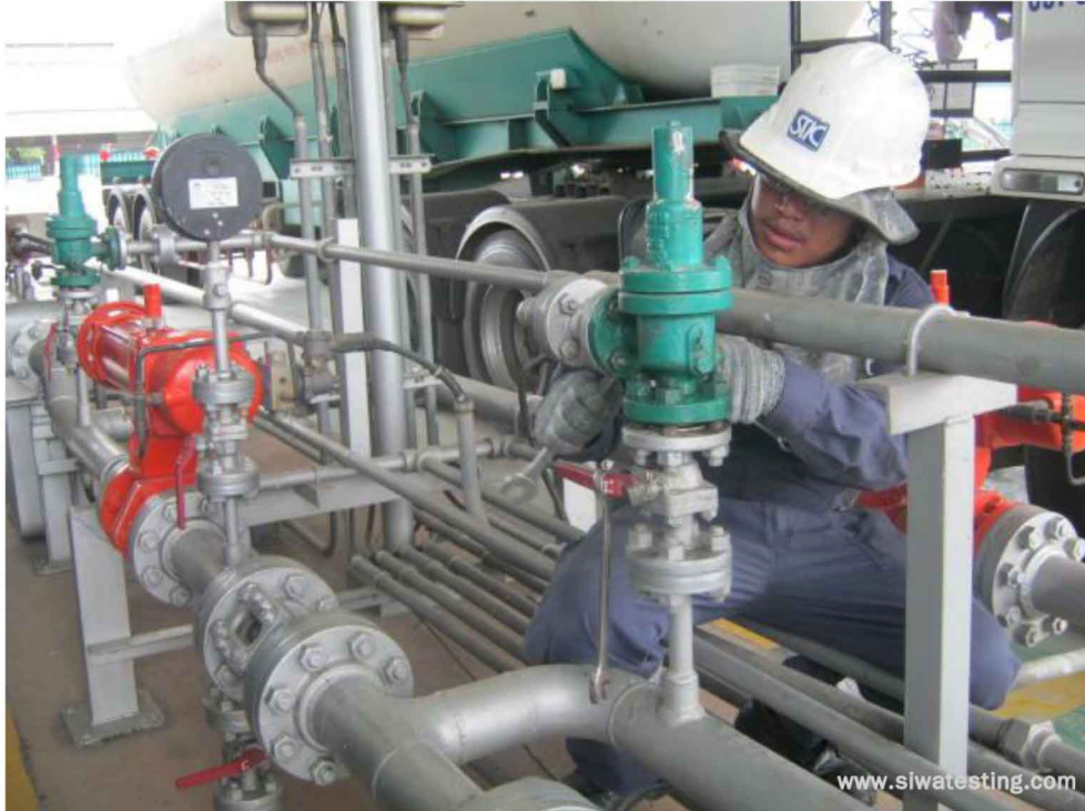
ทดสอบการทำงานของล้นนรภัย
