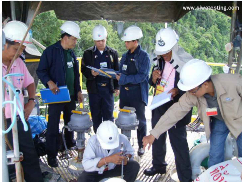
ตรวจวัดปริมาตรของถัง (Tank Capacity Calibration)
