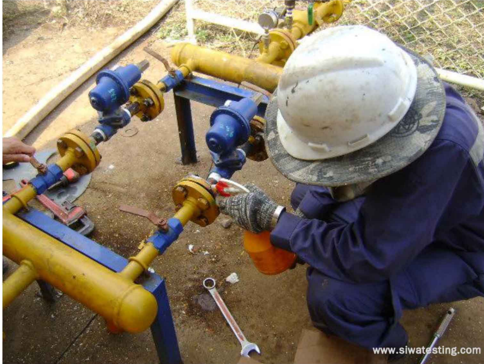
ทดสอบการรั่วซึมของระบบท่อ
