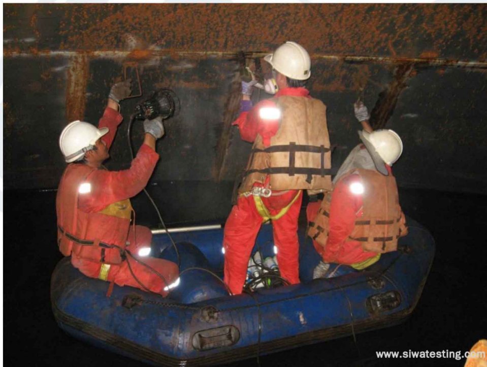
ทดสอบรอยเชื่อมด้วยผงแม่เหล็ก (Magnetic Particle Test) แนวเชื่อมภายในถังขนาดใหญ่ โดยใช้วิธีการลอยเรือแทนการตั้งนั่งร้าน
