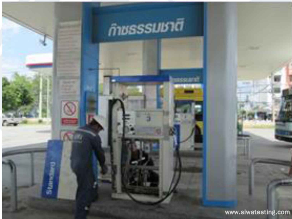
ทดสอบการรั่วซึมของสายจ่ายก๊าซ
