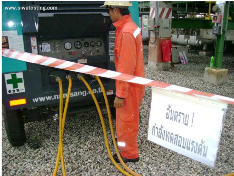
ขณะอัดน้ำเข้าถังเพื่อทดสอบการรับแรงดันของถังด้วยน้ำ (Hydrostatic Test)
